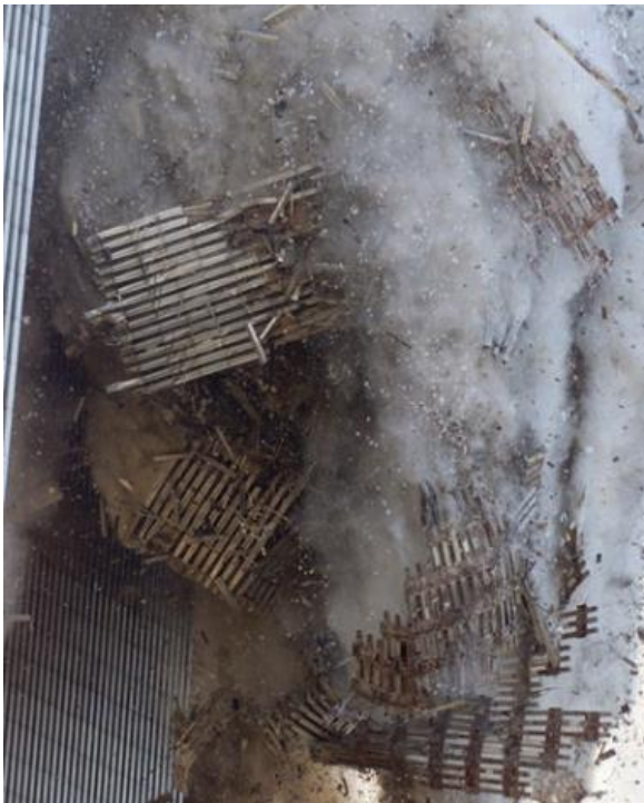
شکل 3-46. صدمات ناشی از اثر ثانویه در حمله به مرکز تجارت جهانی در اثر پرتاب و فرود آوار ناشی از اثر اولیه و یا از ساختارهای در حال فروپاشی رخ داده است. (© Richard Drew / تصاویر AP)
